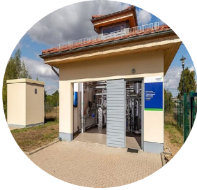
(Foto: Stadtwerke Prenzlau GmbH / September 2018)
