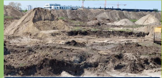
Beräumung und Altlastensanierung
