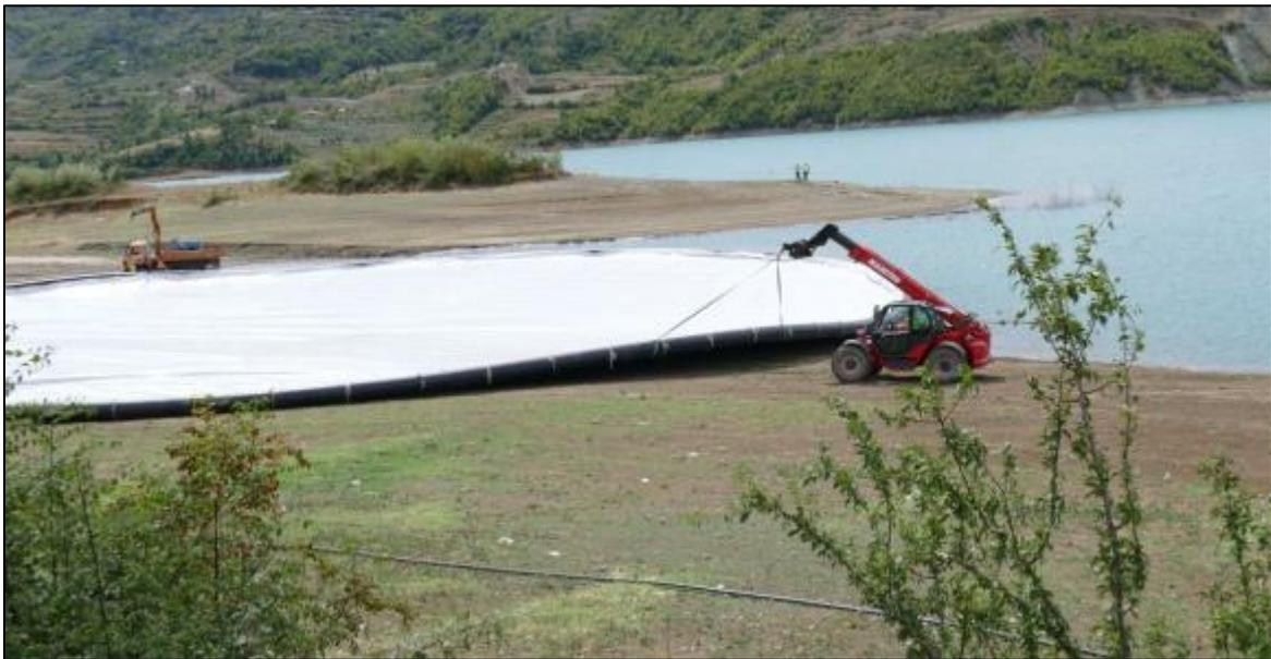
Abbildung 37: Anlage wird nach Vormontage am Ufer in das Wasser gezogen | Quelle: Ocean Sun AS
