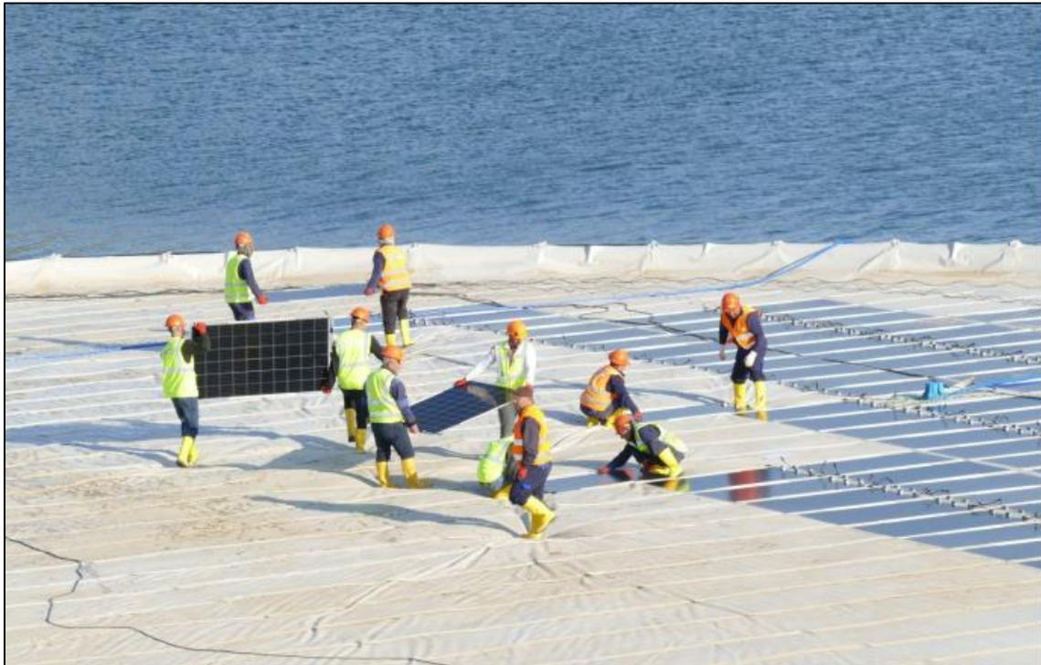
Abbildung 38: Monteure bei der Installation der PV-Module auf dem Wasser | Quelle: Ocean Sun AS
