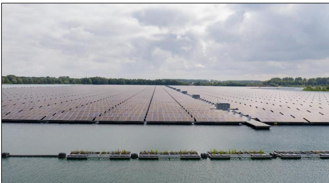
Abbildung 24: Darstellung von zwei verschiedenen Wellenbrechersystemen: links HDPE-Rohre; mittig HDPE-Schwimmer mit Stahlskelett (hier teilweise auch bepflanzt) | Quelle: Zimmermann PV Floating
