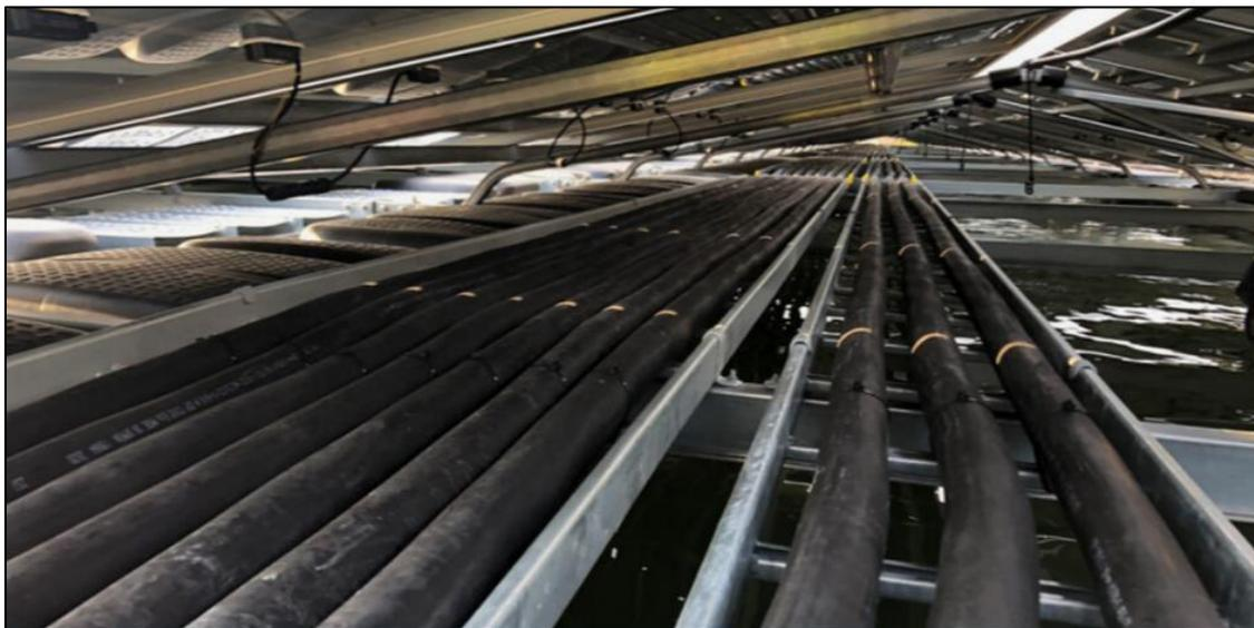
Abbildung 21: Beispiel Kabelführung unter den Solarmodulen | Quelle: Gsun GmbH
