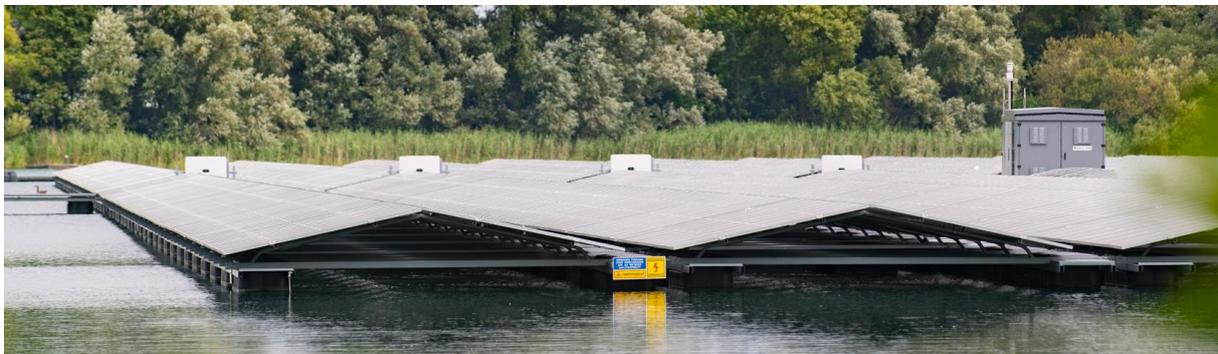
**Abbildung 6: Varianten von Unterkonstruktionen – Rechteckstruktur** | Quelle: Zimmermann PV Floating
