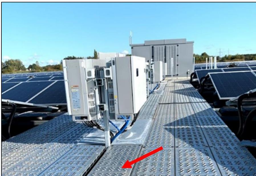
Abbildung 19: abgedeckte Kabelführung unterhalb der Wechselrichter | Quelle: bearbeitet nach Gsun GmbH
