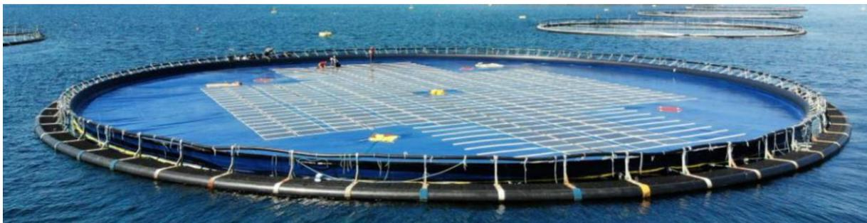
**Abbildung 7: Varianten von Unterkonstruktionen - Ringstruktur** | Quelle: <https://oceansun.no/benefits/#install>
