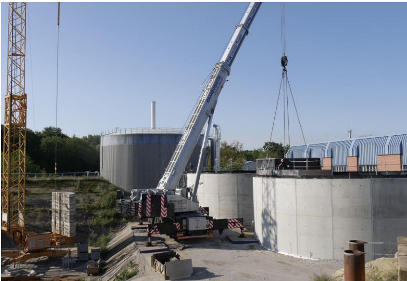
Bau der neuen mechanischen Schlamm entwässerungsanlage auf der Kläranlage Cottbus
