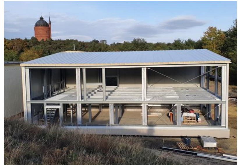
Bau der physikalischen Restentsäuerung im Wasserwerk Sachsendorf. Damit entfällt der Einsatz der letzten Chemikalie im größten Wasserwerk der LWG.
