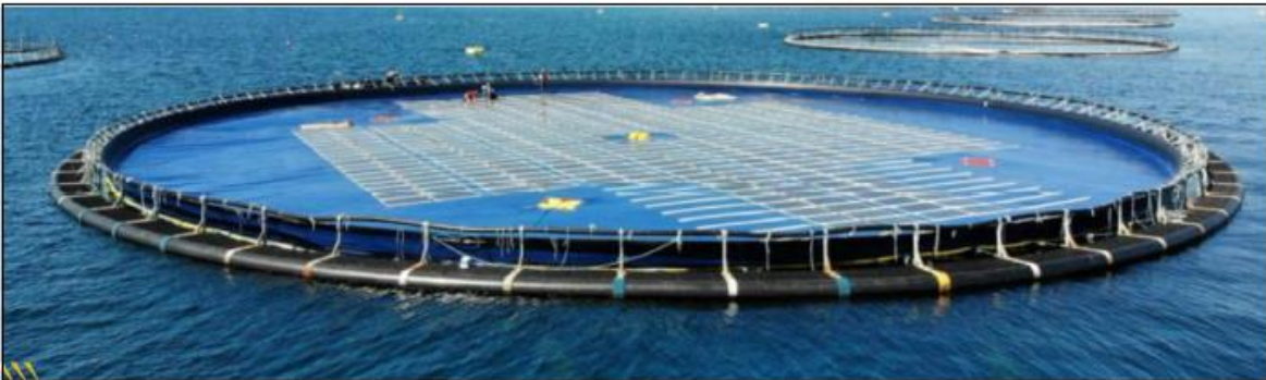
Abbildung 2: Unterkonstruktion für die Ausbaustufe 2 (Ringstruktur) (3)
