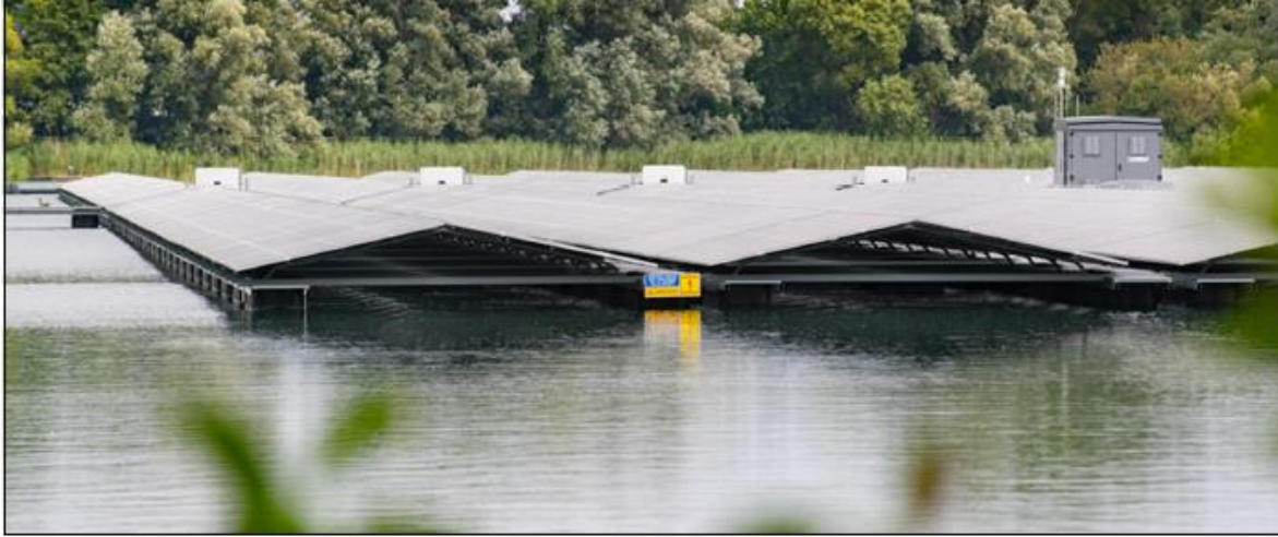
Abbildung 1: Unterkonstruktion für die Ausbaustufe 1 - Hauptanlage (2)
