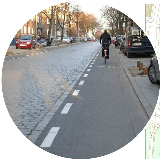
Beispiel für einen asphaltierten Schutzstreifen entlang einer Pflasterstraße (Foto: ADFC, Andrea Kupke)
