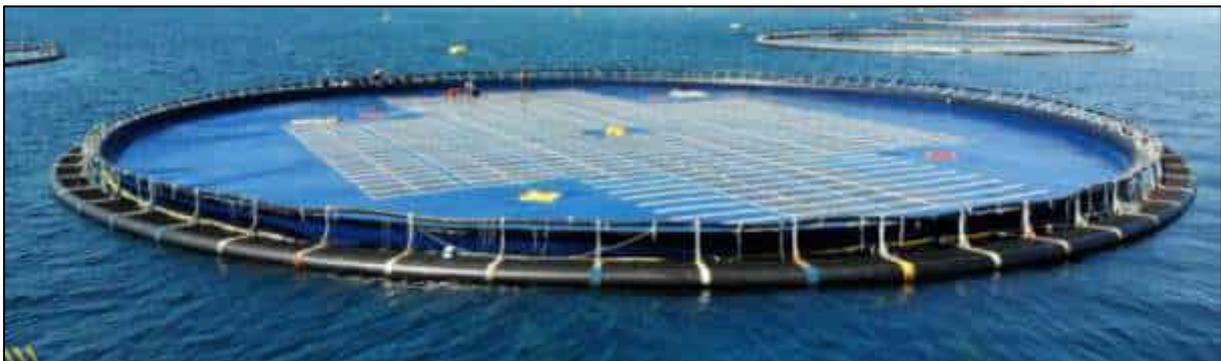
Abbildung 7: Beispiel der Unterkonstruktion für die Ausbaustufe 2 (Ringstruktur) (10)
