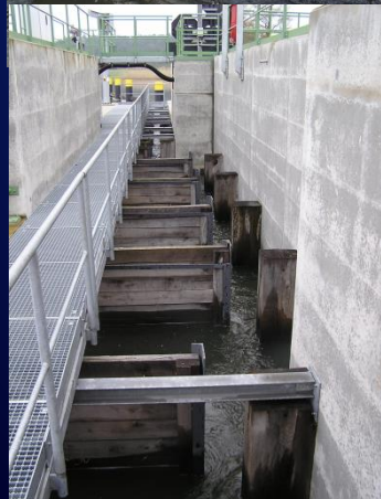
Schlitzpass/ Vertical-Slot-Pass
