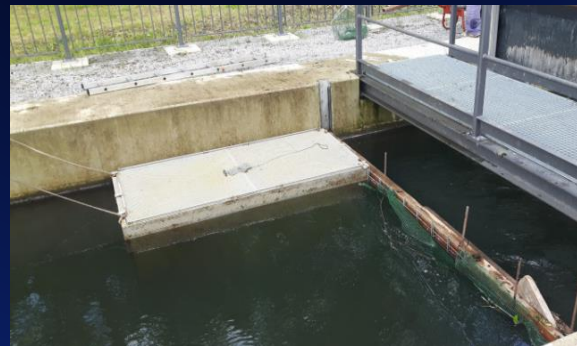
Lochblechkastenreuse, links in fangfähig am Großen Sprewehr Cottbus
