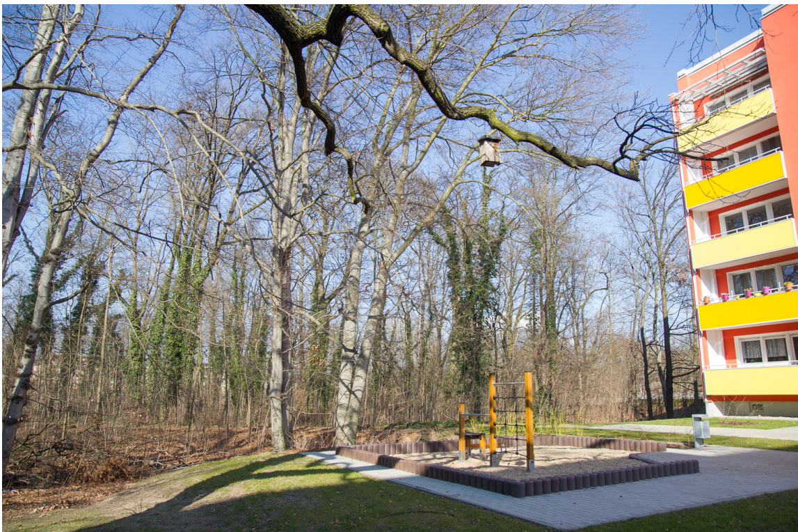
Blick über die Außenanlagen der bereits sanierten „Punkthäuser“ im Norden auf den Auwald nach Nordosten
