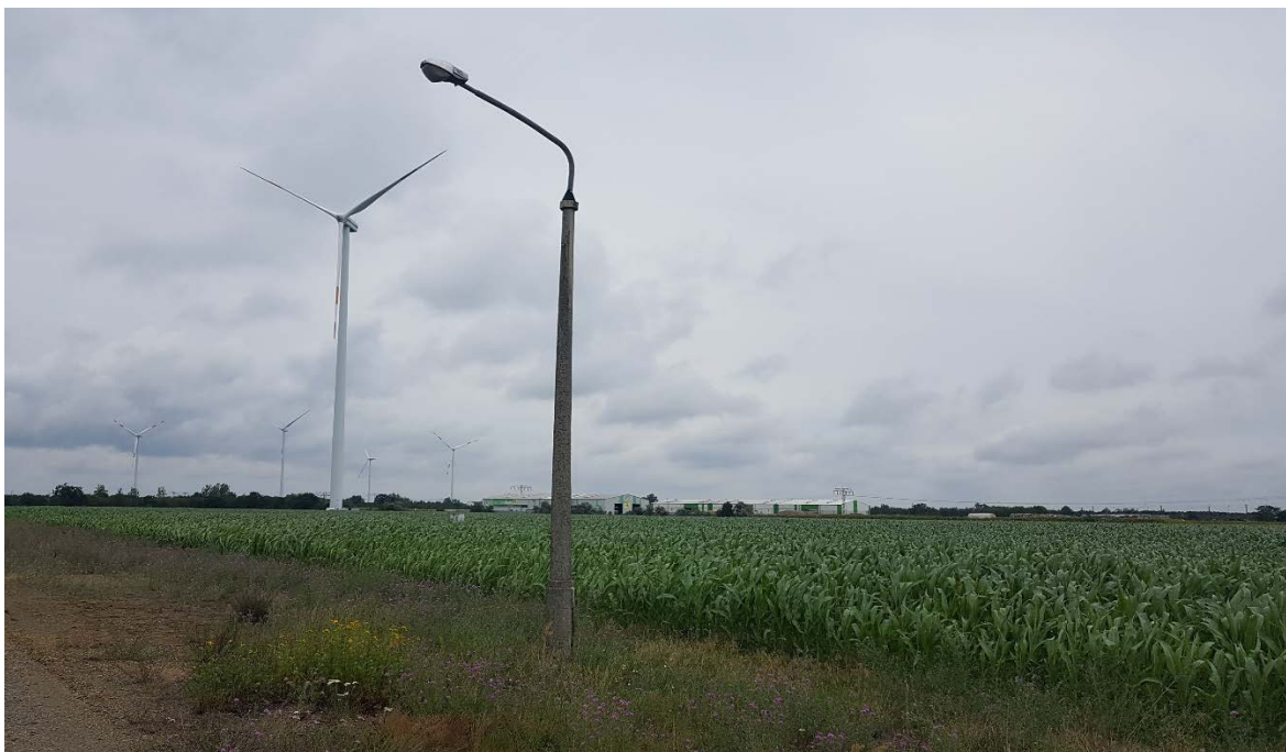
Abbildung 1: Blick auf das Plangebiet Richtung Osten mit der nördlichen WEA, Bild: kollektiv stadtsucht GbR 2020
