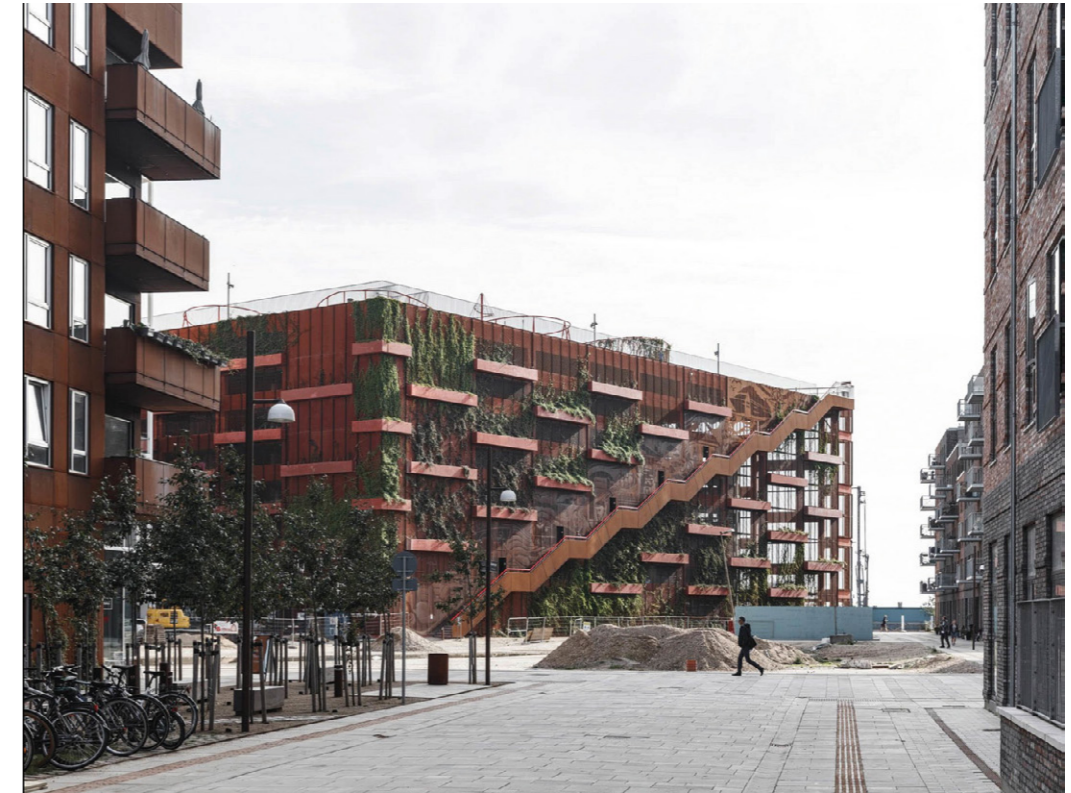
Stahlfassade + Fassadenbegrünung & öffentlicher Treppe
