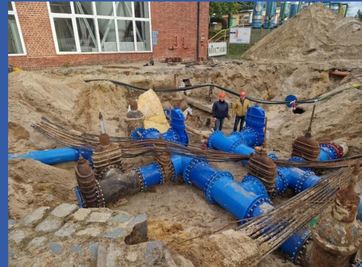
Cottbus, WW I Erneuerung Kaskadenzuleitung.( 870 T€)
